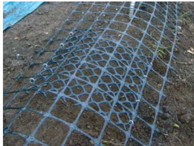
▲ GTフォーム組立状況
