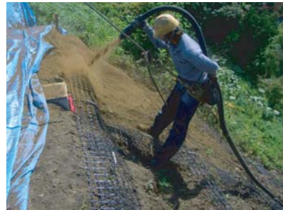
▲ ジオグリッド設置完了後、改良土吹付を行います
